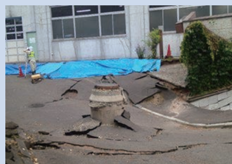
液状化によるマンホールの浮上 (被災箇所の管路属性を整理)
