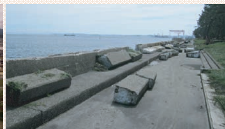
令和元年15号台風の高波による護岸の被災
