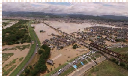
平成30年7月豪雨による堤防の決壊
