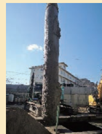
既存杭の撤去工事の状況
