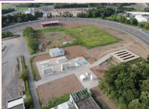
建設DX実験フィールド全景
