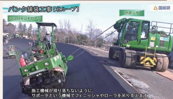
バンク舗装工事
