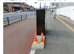
写真-6 電線共同溝の地上機器を歩道と自転車道の間に設置した事例
