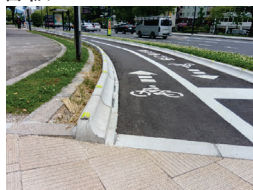
写真-5 縁石形状や視認性を工夫した自転車道整備事例
