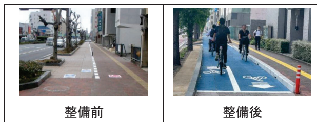
写真-2 歩道幅員を変更した事例
