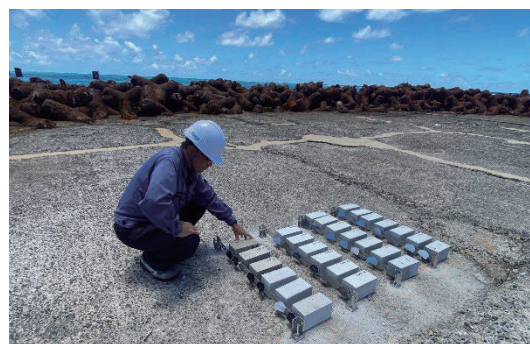
写真-2 沖ノ鳥島観測所基盤での試験体の設置状況
