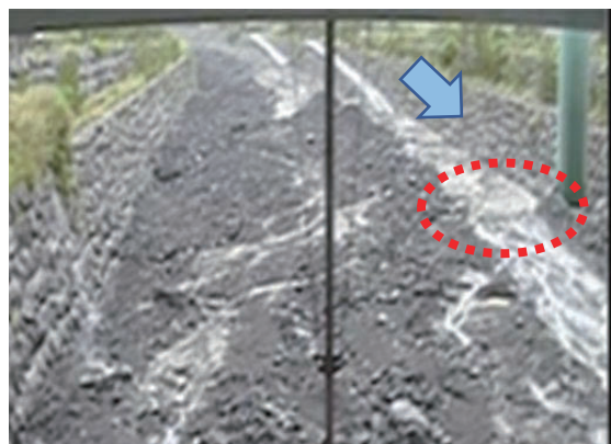
図-1 区間4の下流端到達時のCCTV映像。土石流の先頭部を赤丸で示す。
