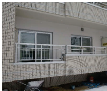
写真-2 外断熱改修による性能向上
