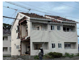
鉄骨造店舗・集合住宅の外壁被害(牧之原市)
