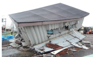
鉄骨造建築物の倒壊(つくば市)
