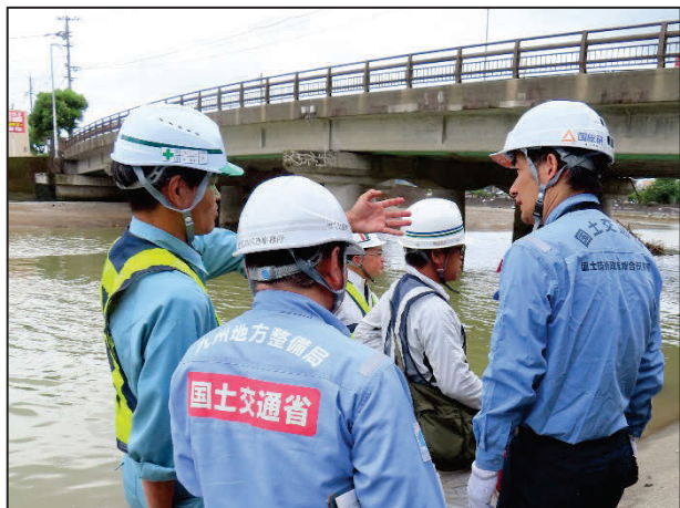
TEC-FORCE による道路橋の被害状況調査の様子 （令和 7 年 8 月 6 日からの大雨）
