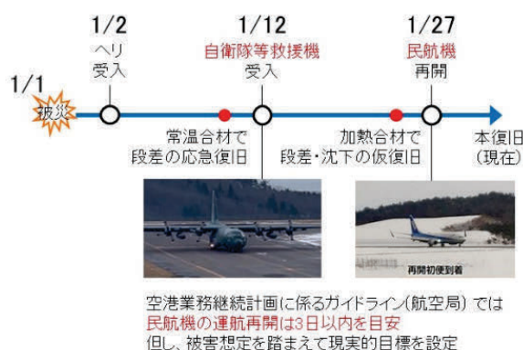
図-1 能登空港復旧タイムライン
