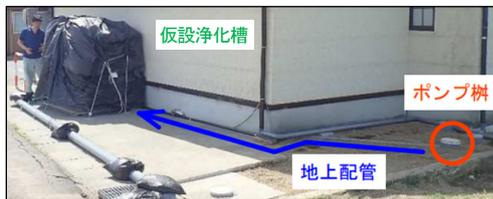
写真-2 仮設浄化槽設置状況
