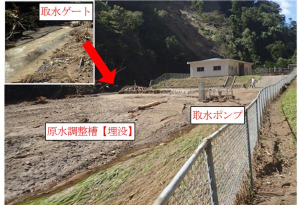
写真-3 大谷浄水場被災状況
