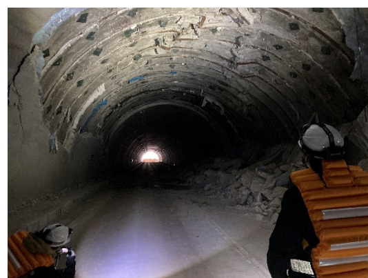
写真-2 下水道施設および道路トンネルの被害状況調査の様子(令和 6 年能登半島地震)
