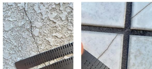
写真-1 仕上げごとのひび割れ画像の例
