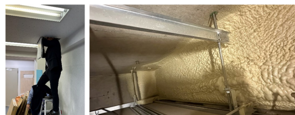
a) 天井点検口から断熱の有無を確認
