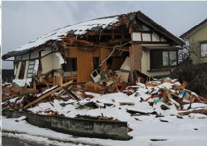
写真-7 倒壊した木造住宅
