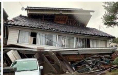
写真-10 倒壊した3階建木造建築物
