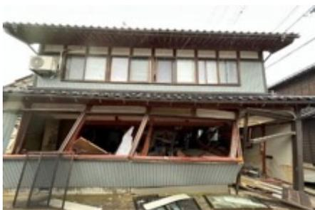
写真-6 大きな残留変形のある
