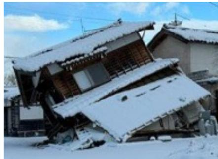
写真-3 倒壊した木造住宅
