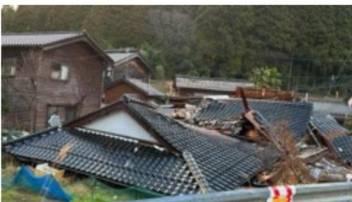
写真-9 倒壊した木造住宅群
