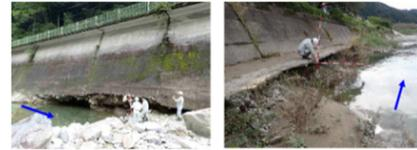
図-6 岩着基礎部の洗掘事例
