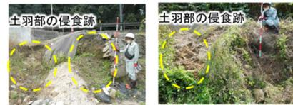
図-7 土羽侵食が確認された未被災箇所の事例
