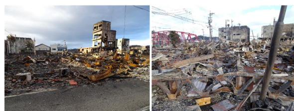
写真 輪島市河井町朝市通り周辺火災
