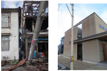
写真 延焼区域の境界に残る建物の例
