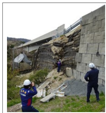
写真-3 橋台背面接続区間の被災メカニズムの調査
