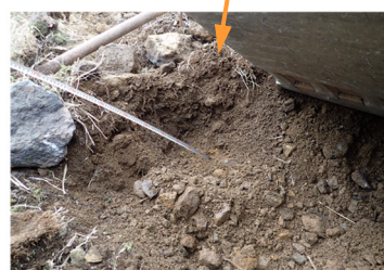
リップラップ変状箇所背面の調査（堤体のすべりを疑わせる変状なし）
