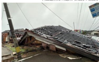
倒壊し道路閉塞した建築物
