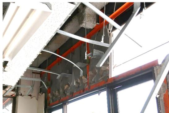
写真 支持部を含む窓における地震被害の例<sup>1)</sup>
