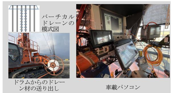
図-3 ICTを活用したバーチカルドレーン工（ペーパードレーン工）
