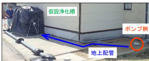
写真-2 仮設浄化槽設置状況
