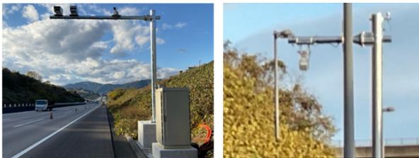
(a) 車両検知センサ (b) 情報提供施設
