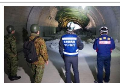
写真-2 覆工が大規模に崩落したトンネルの調査
