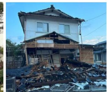
写真-11 部分崩壊した木造住宅
