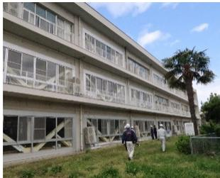
耐震改修を行った鉄筋コンクリート造建築物（倒壊・崩壊の被害なし）
