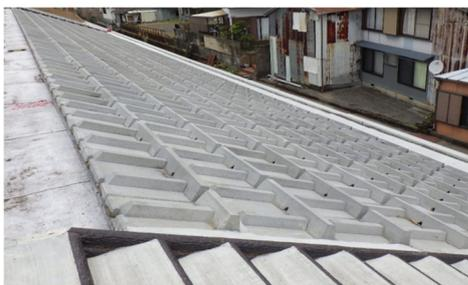
写真-2 粘り強い河川堤防の例
