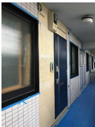
写真 マンションの外断熱改修例
