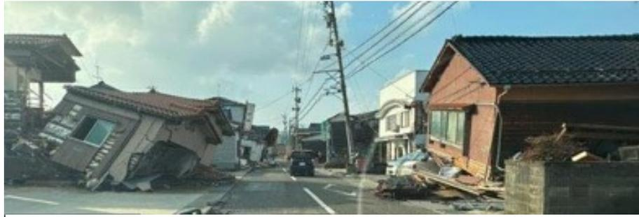
写真-1 倒壊した木造住宅群
