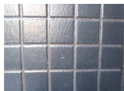
写真-1 透明樹脂系ピンネット工法による改修外壁
