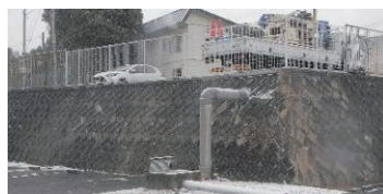
図-1 調査対象擁壁
