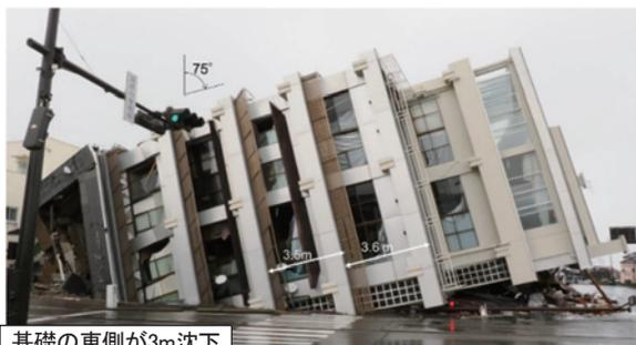
写真-1 転倒したRC造建築物(南側から撮影)
