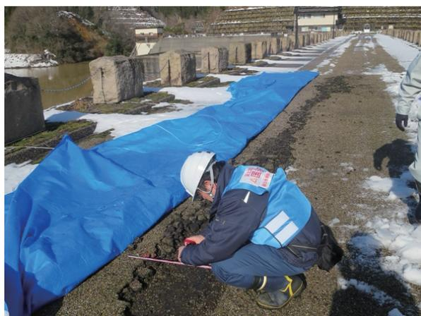
写真-4 能登半島地震で被災したダムへの調査
