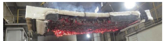
写真 合成床試験体の耐火試験（試験後）
