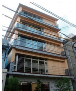
写真-2「立面木質混構造」の事例:階によって構造が異なる混構造で、本事例は1階がRC造、2～5階が木造（CLT）
