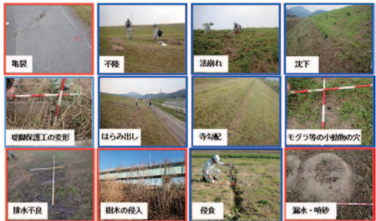
赤色：画像で抽出可能 青色：三次元点群で抽出可能 変状自動抽出の対象とした堤防変状
