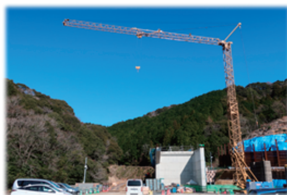
図-3 定置式水平ジブクレーン
