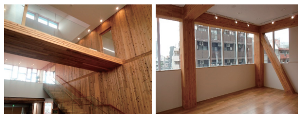
写真-1 主要構造部材である木材をそのまま見せる設計 (左:中層大規模建築物、右:高層建築物)
