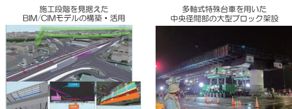
(a) 大樋橋西高架橋工事
