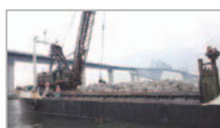
写真 人工石を投入する作業船
