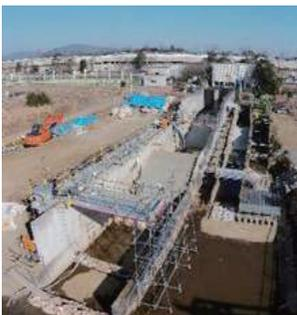
高落差実験水路では、実物に近いスケールの模型を用いて、堤防等の河川構造物に作用する外力とそれらの破壊機構を検討し、合理的な河川構造物の設計法について検討しています。
