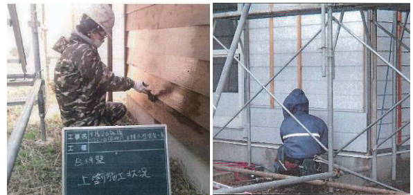
図2 保護塗料の塗替え(左)とカバー工法(右)
