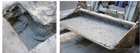
図3 低強度コンクリートによる埋め戻し（台湾）
