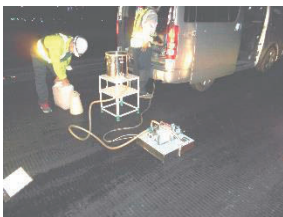
写真-1 DFテスト (測定状況)
