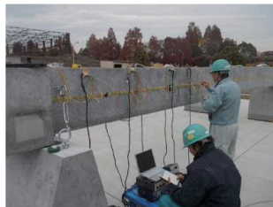
写真-1 非破壊調査状況
