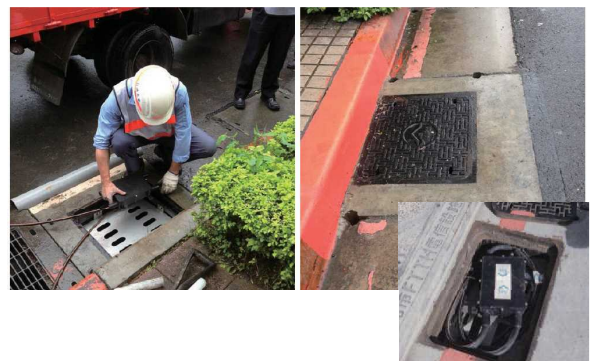
図1 側溝を活用した通信線の設置（台湾）
