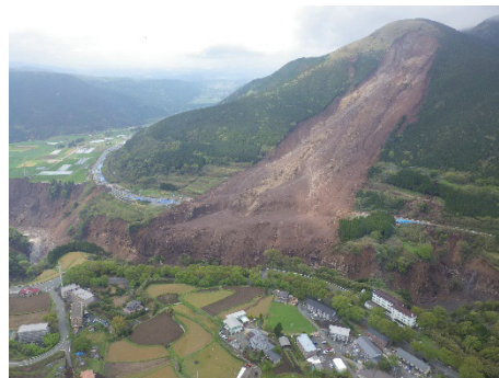
地震時の大規模斜面崩壊 (H28 熊本地震)
