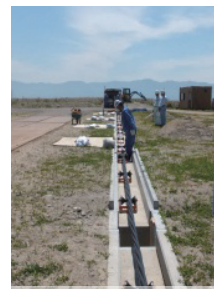
小型ボックスへの 通線時施工試験
