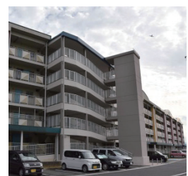
2つの住棟間へのエレベータ設置（バリアフリー改修）例
