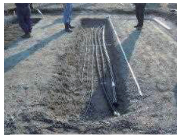
ケーブルの浅層埋設 に関する施工試験
