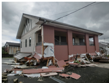
熊本地震で倒壊した木造アパート (2000年以降に建築)
