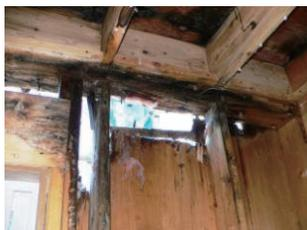
写真1 耐力壁の劣化状況
