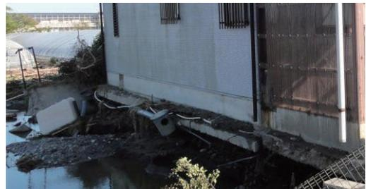
写真-2 家屋基礎下の洗掘(図-1のb)
