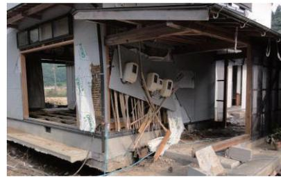
写真-1 外壁や建具の損壊(図-1のa)
