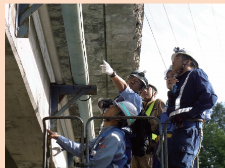
写真 直轄診断における現地調査
