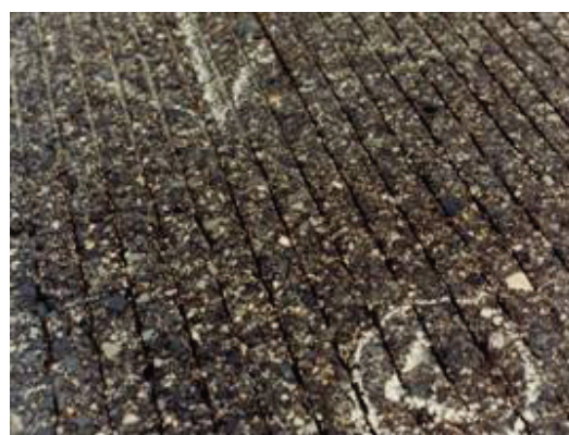
写真－1 グルーピング溝のつぶれ
