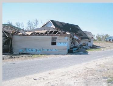
写真-2 流出した家屋
