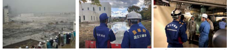
津波により水没する下水処理場 台風による浸水の被災状況調査 汚水ポンプ場の浸水の被災状況調査
