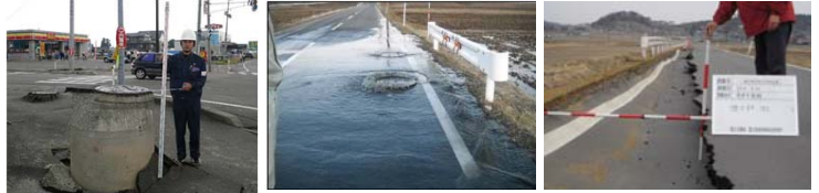
液状化によるマンホールの突出 管きよの流下機能障害による被害 管きよの被災状況調査
