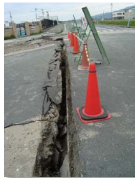
液状化によって生じた 臨港道路の段差 (熊本港・人工島)
