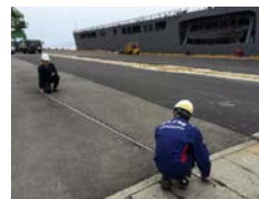
液状化によって生じた 臨港道路の段差 (熊本港・人工島)
