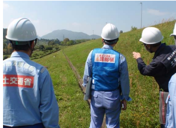
緑川ダムにおける現地状況調査 (大規模河川構造物研究室長)
