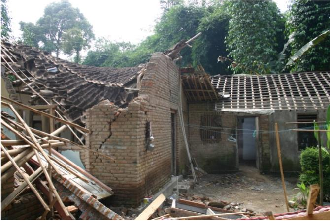
写真は焼成れんが壁の四周を補強されていない戸建住宅の被害（地盤が良好なところ）です。崩壊した要因はひとつが要因ではありませんがこのような被害は建設時にれんが壁の四周を鉄筋コンクリートで囲（補強）む住宅造りをする事で瞬時の崩壊を防ぐことにつながります。火山灰堆積土を使用したれんがについてもれんがの造り方、力学的挙動、施工法などの技術的な検討により利用が可能となります。エルサルバドルやインドネシアなどの火山国では、組積造に住まうことが一般的です。
