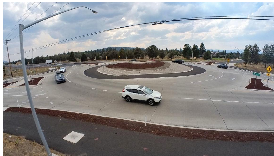
海外の片側2車線道路のラウンドアバウトの例 (日本では未導入。写真提供：日本大学 吉岡 慶祐 准教授)
