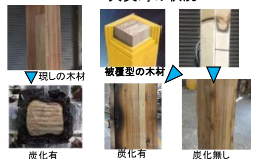
火災後の構造部材状況
