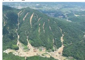
同時多発的な表層崩壊や土石流
