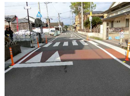
追加設置した スムーズ横断歩道
