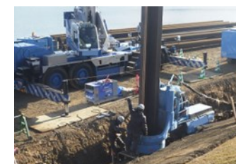
油圧圧入引抜工
