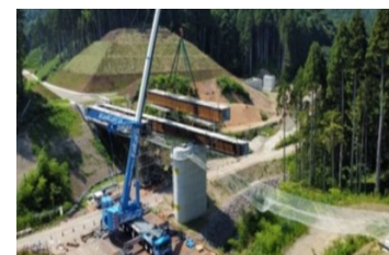
鋼橋架設工
