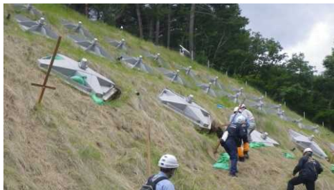
(法面変状への対応に関する技術支援)
