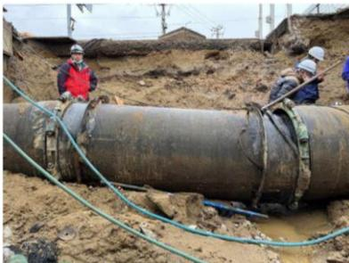
送水管の損傷（七尾市）
