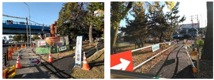
工事箇所の歩道を常設作業帯とするため、沿道の公園内に歩行者通路の設置した事例
