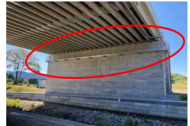
工種名：橋梁検査路架設工
