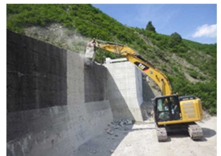
工種名：コンクリート工 (砂防) 改定概要：日当たり打設量区分見直し、チッピング工等を新規に設定
