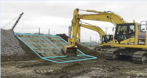
建設機械の刃先履歴データを用いた出来形管理
