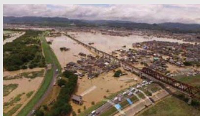
平成30年7月豪雨による堤防の決壊
